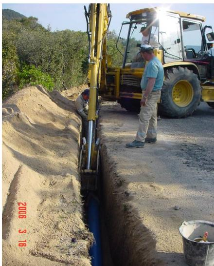
A gauche : Pose des tuyauteries Diam. 150 en fonte
